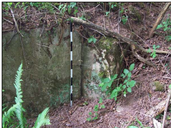
▲ [5018754] Die nachträglich betonierete Flügelmauer an der linken hofseitigen Ecke des Hofes.
