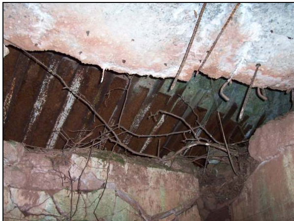
▲ [5018761] Diese Trägerdecke wurde bislang der Gasschleuse zugeordnet, aber das bedarf noch mal einer Prüfung.
