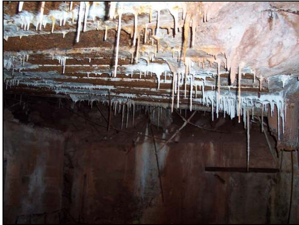
▲ [5018759] Blick in den rechten Bereitschaftsraum: Die Innenseite der rechten Seitenwand.
