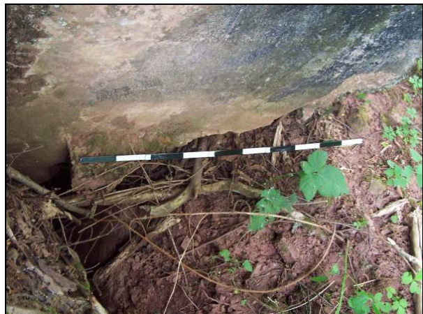
▲ [5018752] Die Hofüberdeckung fing nicht erst mit der Deckenstufe des angehängten Kampfraumes an, sondern schon ein Meter weiter an der Decke des angehängten Kampfraumes.
