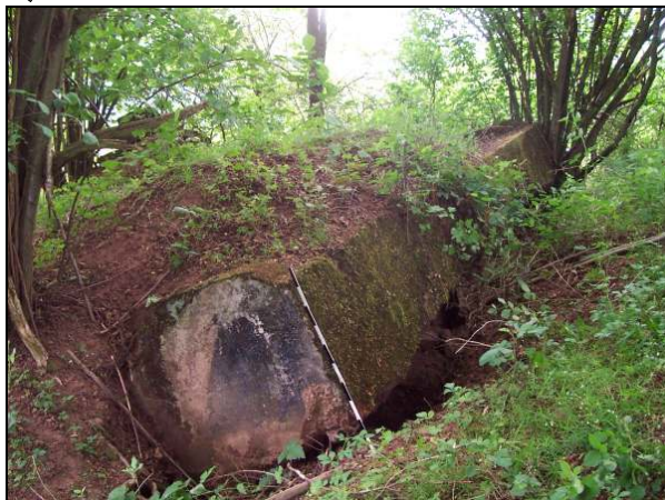
▲ [5018751] Ansicht von Osten mit der Decke der Hofüberdeckung: Links unten der Eingangsbereich.
