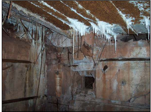
▲ [5018760] Im rechten Bereitschaftsraum: Die Innenseite der rechten Gewehrscharte.
