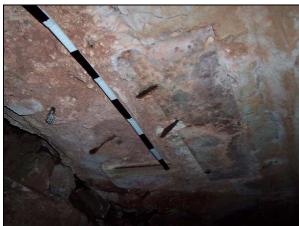
▲ [5018756] Die Unterseite der Decke der Hofüberdeckung: Das Ende des überdeckten Hofes (rechts) und die Spuren der Stirnwand bzw. rechten Seitenwand.
