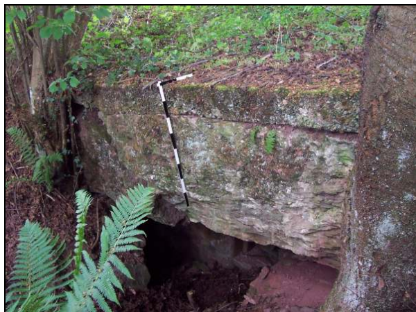
▲ [5018753] Ansicht von Norden: Die Rückseite der Decke der Hofüberdeckung, die nach dem Bau von Erdreich verdeckt wurde. Hier zeigt sich die magere Qualität des Baumaterials. Darunter ist der rechte Eingangsbereich mit der rechten Gewehrscharte zu sehen.
