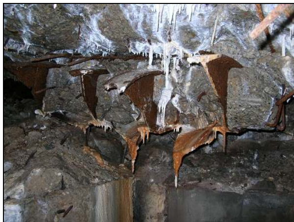
▲ [5015604] Im linken Bereitschaftsraum: Die Deckenträger wurden wo es möglich war abgeschnitten und verschrottet.
