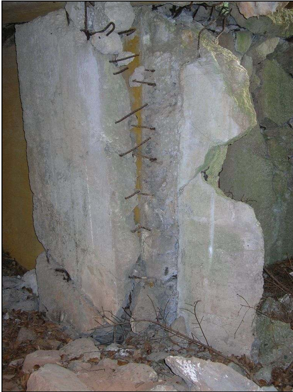
▲ [5015602] Die zweite Trennmauer im Eingang wurde durch die Druckwelle der Sprengung abgerissen und gegen die Seitenwand geklatscht.
