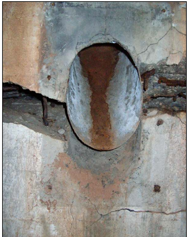
▲ [5017619] Die untere Mündung des Ofenrohres, mit dem Schatten eines Rahmens für eine Verschlussklappe.
