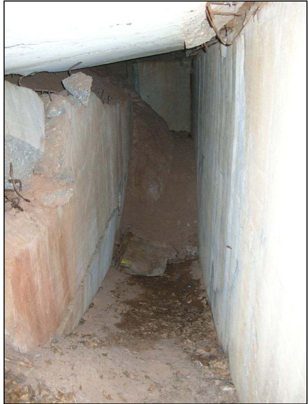
▲ [5015614] Blick durch die Hofüberdeckung von links nach rechts. Links im Bild die Hofwand des Unterstandes.
