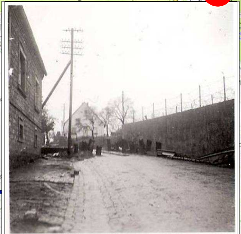
▲ Zwischen der Höckerlinie und der Panzermauer quert die St.Ingberter Strasse das „Kampfwagenhindernis“, das hier mit einem Steckschienehindernis geschlossen wurde. (Bild: (Quelle unbekannt))
