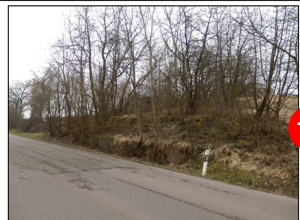
▲ [5020726] Ansicht von Norden auf das Querfundament am westlichen Rand der Straße Oberwürzbach-Ommersheim.
