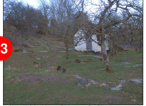
▲ [5020570] Ansicht von Südwesten: Der Blick von unten auf das ansteigende Gelände offenbart leicht sämtliche Fundamente. Im Vordergrund die Reste der frontseitigen Höckerreihe.
