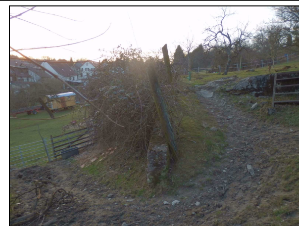
▲ [5020571] Ansicht von Südosten: Das frontseitige Fundament (rechts) endet an der Panzermauer, die hier von einer dünneren betonierten Hangschutzwand verlängert wird.
