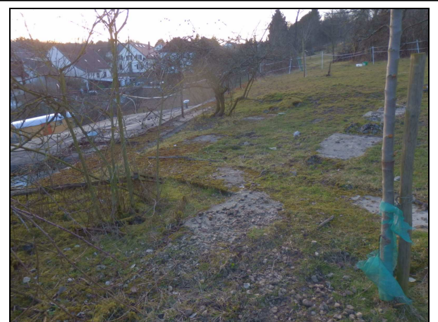
▲ [5020569] Ansicht von Osten: Der Übergang vom Höckerhindernis (rechts) zur Panzermauer (links).
