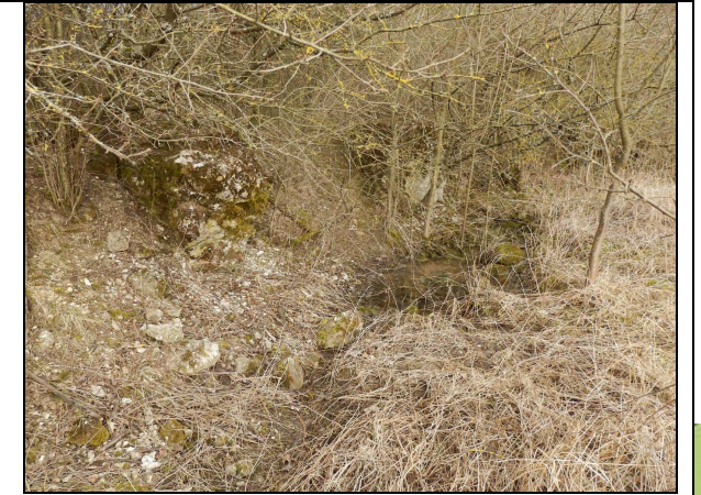
▲ [5020542] Südlich vom Staffelköpfchen: Das fehlende frontseitige Fundament hat einen wassergefüllten Graben hinterlassen, worin Betonschutt liegt.
