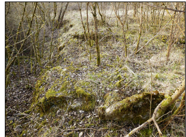
▲ [5020608] Nordöstlich von Heckendalheim sind die Fundamente in einem ruinösen Zustand im Gebüsch vorhanden.
