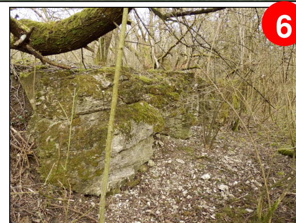
▲ [5020538] Südlich vom Staffelköpfchen: Nur hier wurde das frontseitige Fundament entfernt.
