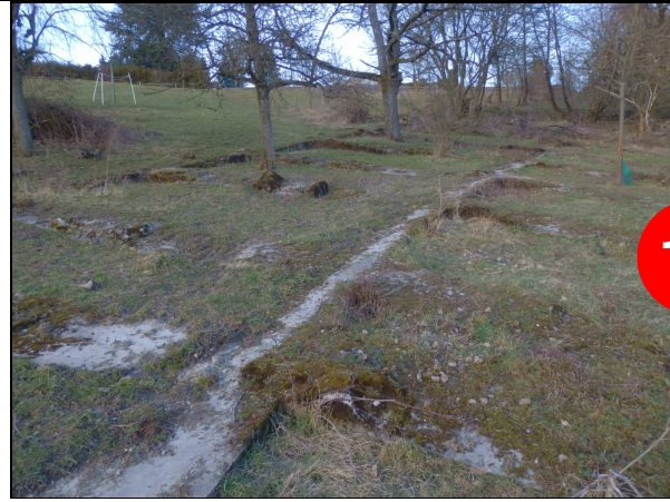
▲ [5020566] Ansicht von Südwesten: An den Querfundamenten sind die Reste der Höcker noch erkennbar. Ein solcher Anblick ist selten, weil zerstörte Höckerlinien entweder verschüttet oder überwachsen sind.
