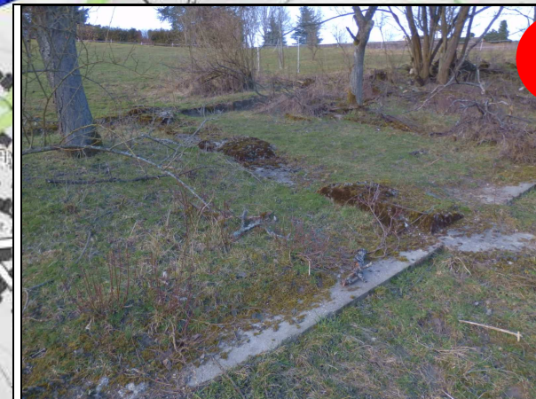
▲ [5020565] Ansicht von Süden: An den Querfundamenten sind die Reste der Höcker noch erkennbar.
